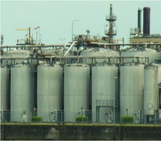
Chemiearmaturen (Ventile, Rührwerke, Pumpen)
